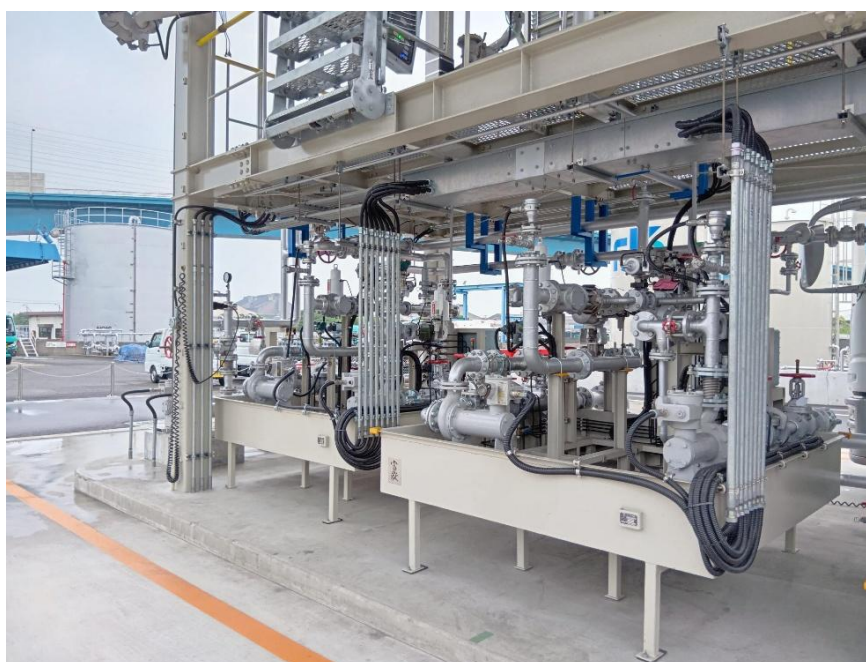
（写真）姫路製造所におけるバイオ重油の混和・製造設備
